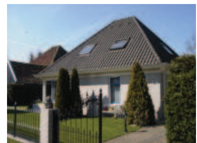
witte steen als hoofddrager is niet toegestaan
