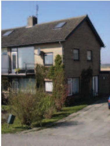
een pand waarbij niet genoeg aandacht is besteed aan de plaats van de entree
